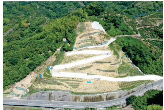
復旧の様子（令和4年7月）
