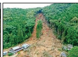
山腹崩壊の状況
